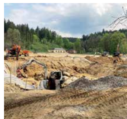
Bauarbeiten in Weitersfelden.
