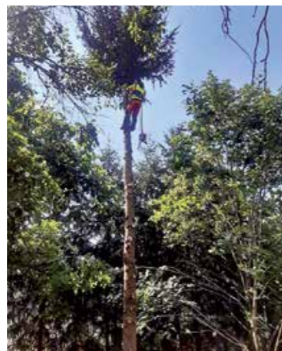
Baumabtragungen in Siedlungsgebieten mit Steigeisen und Motorsäge. Foto: David Fuchsichler
