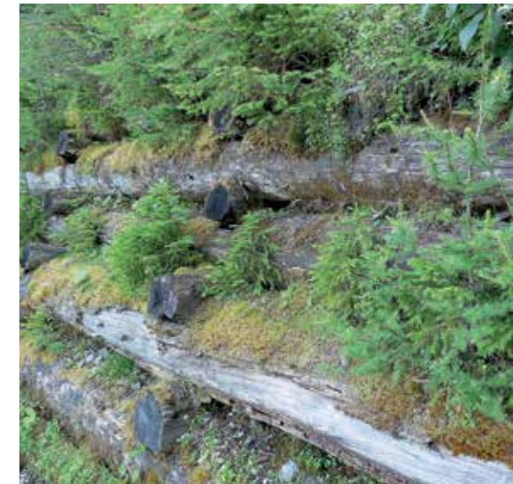
Strukturreiche Oberböschung auf Holzkrainerwand.
