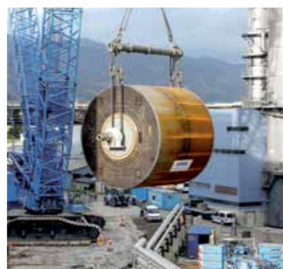
Ein 1.200 to Spezialkran hebt den Trockenzyylinder in die Maschinenhalle.
