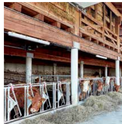
Stallgebäude Fam. Zöhrer – gebaut mit eigenem Holz vom örtlichen Zimmereibetrieb.
