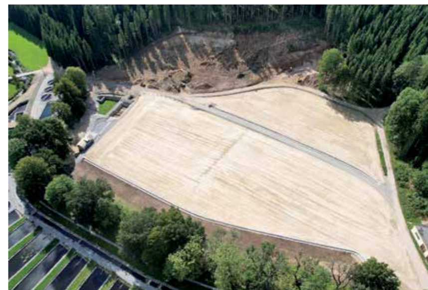
Flugaufnahme vom Nasslagerplatz in Weitersfelden kurz vor Fertigstellung.
