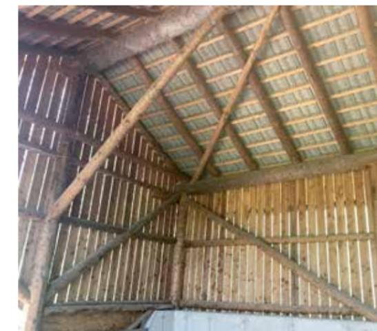
Die Rundholzkonstruktionen wurden anschließend mit Lärchenbrettern verschalt.
