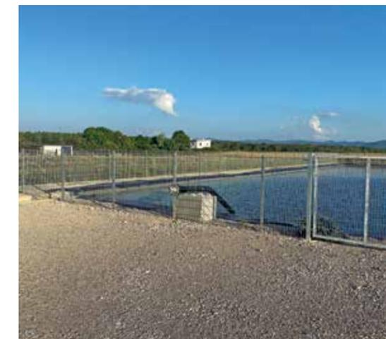
Löschwasserentnahme durch eine Steigleitung.
