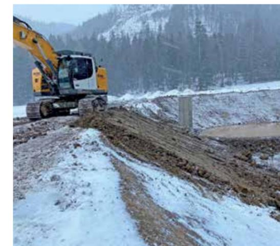
Die Errichtung eines Löschteiches mittels Lehm Schlag.
